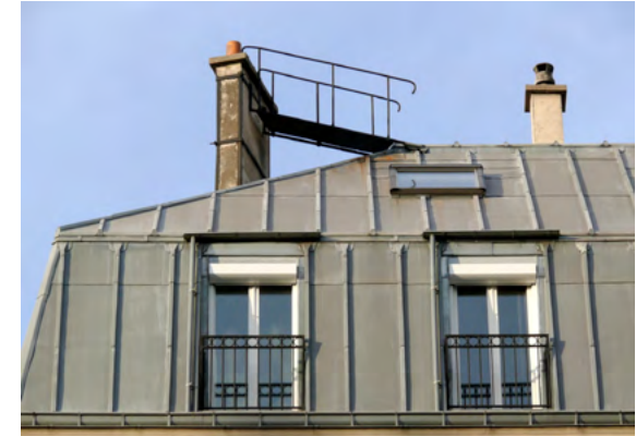
Toiture en zinc
