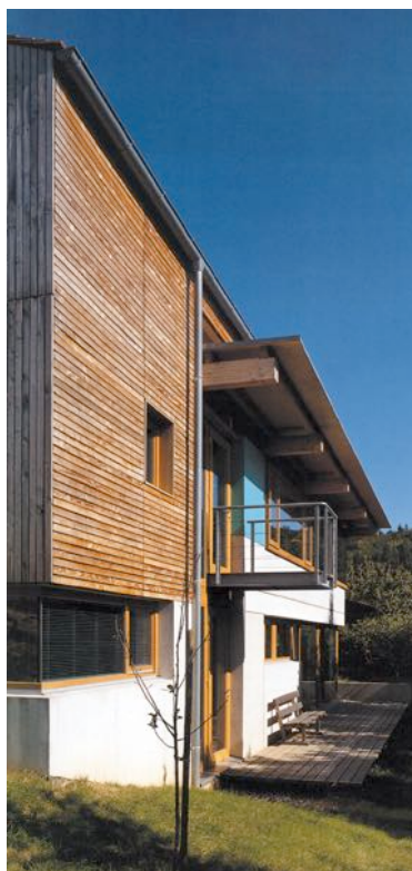
Bois sur socle massif, cette maison de 108 m 2 sur 5,26 ares s'inspire de la tradition locale tout en exploitant la vue et l'ombre des arbres du terrain.
