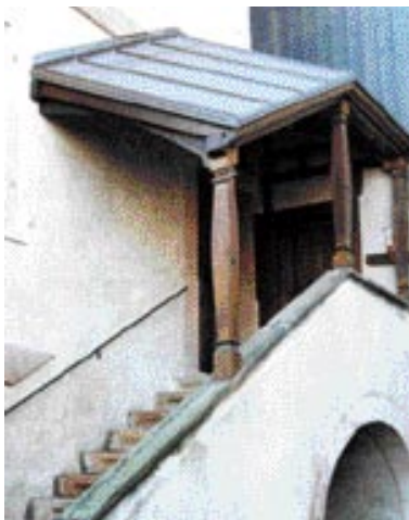
Auvent avec couverture en cuivre
