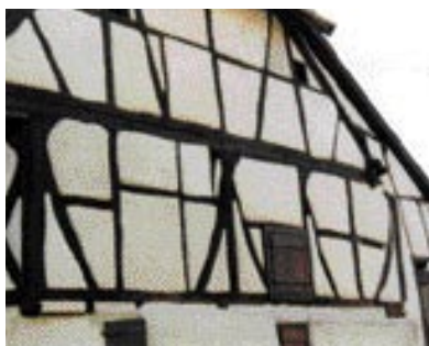
Enduit à la chaux aérienne naturelle. Le rafraîchissement de l'enduit
