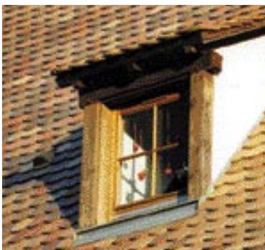
Lucarne et couverture en tuiles plates à double recouvrement
