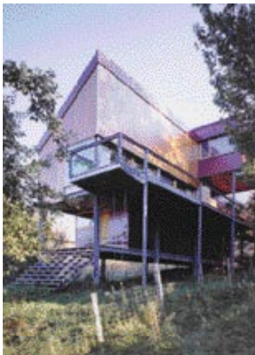
Structure acier galvanisé, panneaux en contre-plaqué
